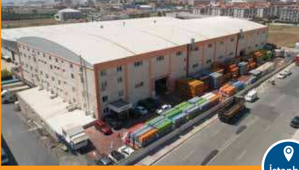
Vana ve PP-R Sistem Üretim Tesisi
