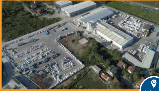
PVC-U Sistem Üretim Tesisi
